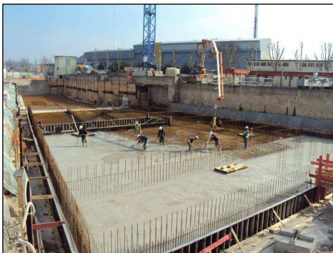
11/03/2010 : coulage du radier de la bache n°15
