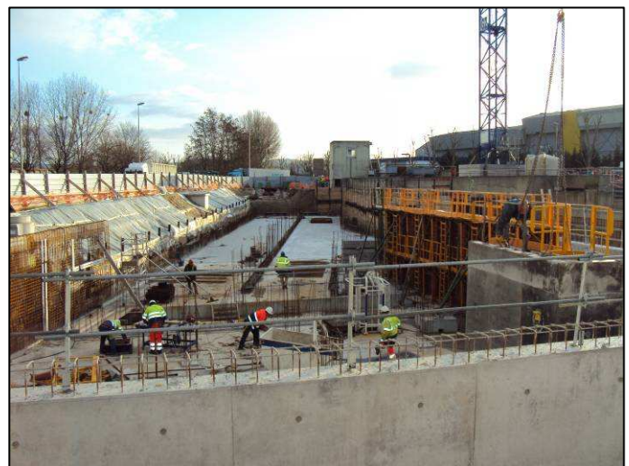
01/04/2010 : réalisation des voiles de la bache n°15 en cours
