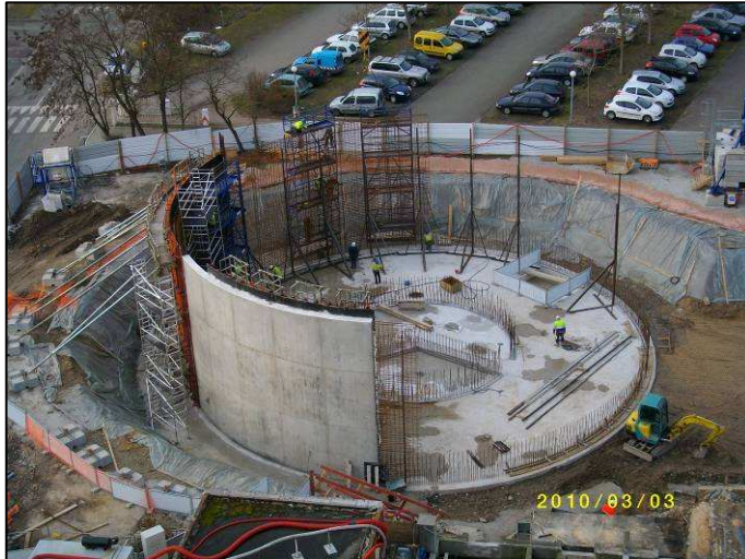
03/03/2010 : Bassin biologique 2, premier voile coulé
