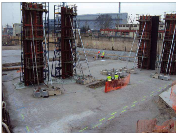
17/02/2010 : Préparations en vue du ferrailage de la bache
