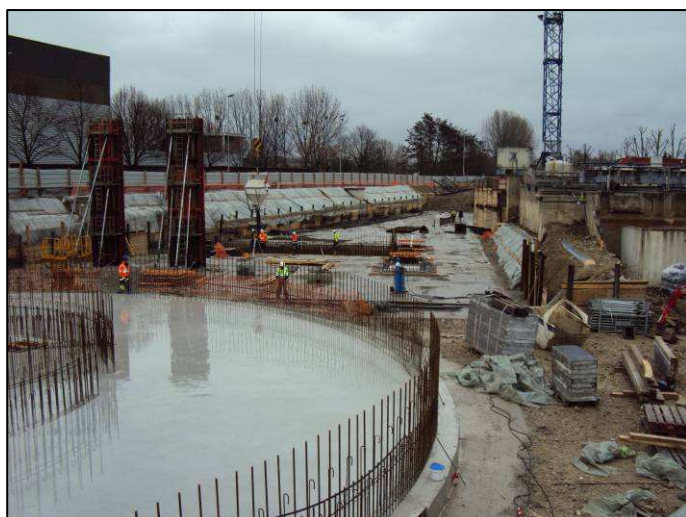
25/02/2010 : Radier du Biosep 1 et ferrailage de la bache
