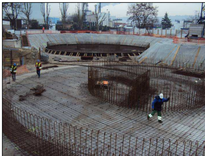
17/02/2010 : Finalisation du ferrailage du Biosep 2
